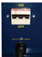
Выключатель 32 А дуга D
